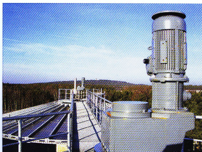
Fermenter mit Rührwerk
